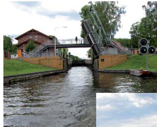
Schleuse Neue Mühle
