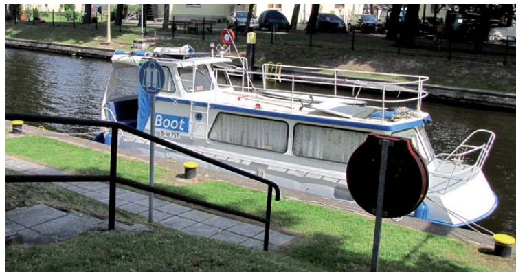
Sportbootanleger Schleuse Neue Mühle
