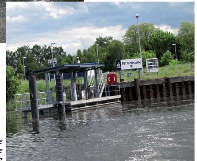
Die Wassertankstelle hinter der Schleuse Neue Mühle
