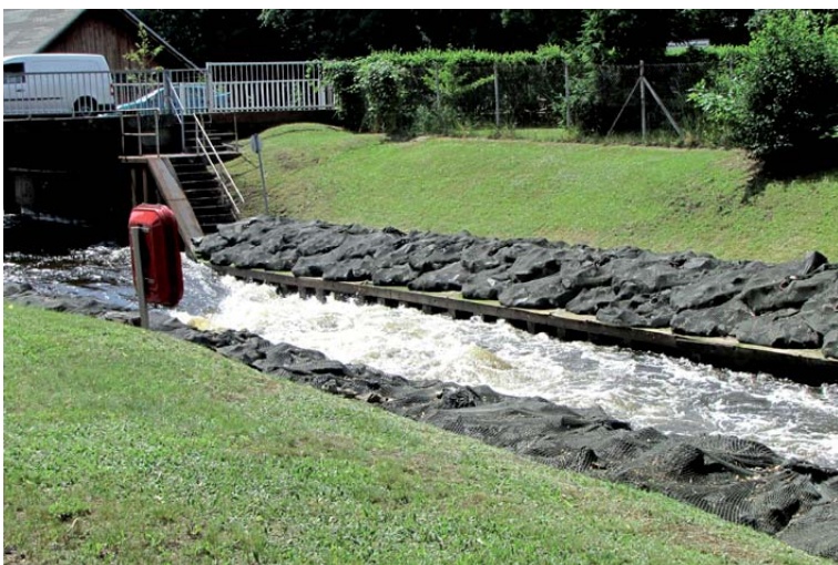
Das neugebaute „Zusatz-Wehr" an der Schleuse Neue Mühle, um mehr Wasser ablassen zu können, was hier auch gut strömte (ehemals Bootsschleppe)
